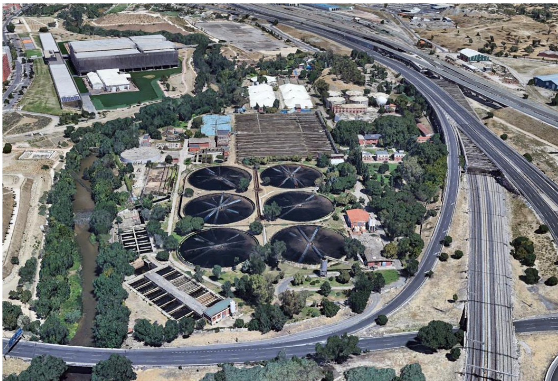
Figura 8. Vista aérea de la EDAR Sur de Madrid.
